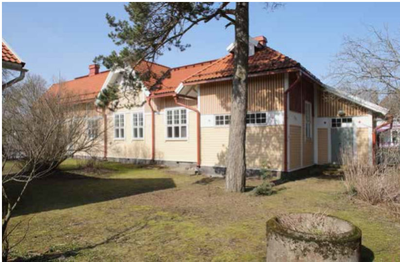
Kuva 4. Asemarakennuksen sisäpihaa. Ark-byroo Oy, 2020.
