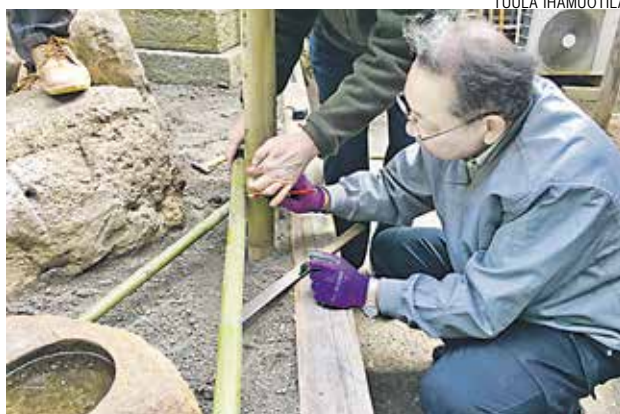
Bambuidaidan rakentamiskoulutus käynnissä. Här byggs bambustaket.
