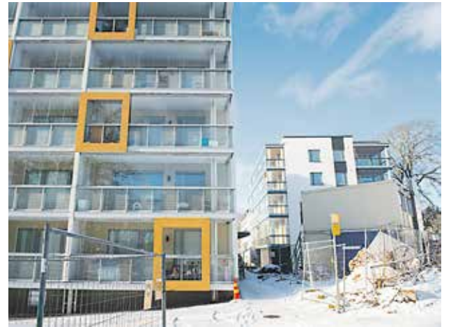
Tämä hanke on vaatinut ahtaan rakennuspaikan vuoksi paljon huolellista työmaan suunnittelua ja osin tilapäisjärjestelyjä, mutta erittäin hyvin on mennyt, sanoo Marja Kuosma Skanska Kodeista.
