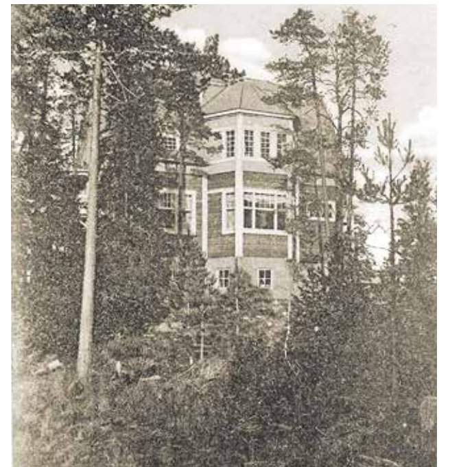
Vid Stationsvägen 13 fanns en stor villa, den sk Pettersons villa. Kortet är poststämplat 20.2.1913. På 1970-talet byggdes Medix på platsen och nu kommer även den byggnaden att rivas för våningshus.
