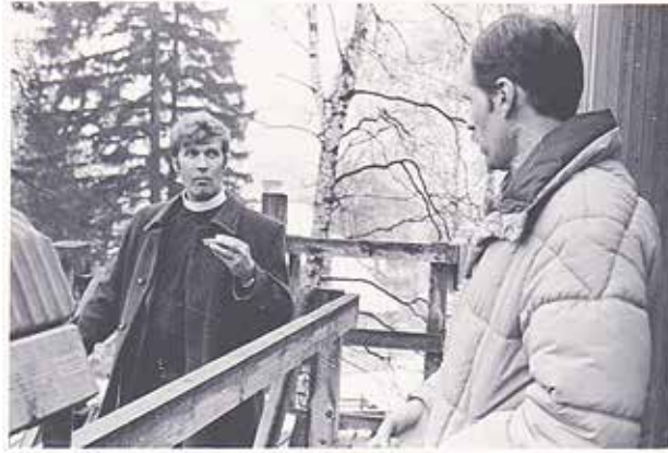
Harjannostajaisissa 31 vuotta sitten uusi kirkkoherra Arto Laitinen keskustelelee rakennusmestari Harri Räikkösen kanssa. Peruskivi murattiin 17.12.1982 ja harjannostajaisia vietettiin 25.3.1983.
