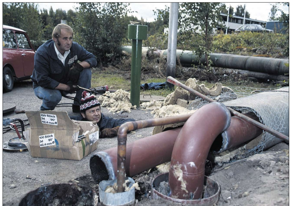
Kaukolämpöputket sukeltavat maan uumeniin. Fjärrvärmerören dyker in i marken.
