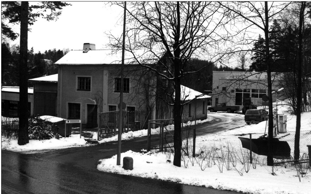
Rakennusvirasto Oppilaskodintie, 1990-luku. Vanha sähkölaitos oli matalassa rakennuksessa (kaksi kapeaa ikkunaa). Byggnadskontoret vid Elevhemsvägen, 1990-talet. Det gamla elverket fanns i den låga byggnaden med två smala fönster mot infartsvägen.
